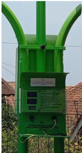
Gambar 5. Pemasangan Panel Box dan Instrumentasi pada Ruas Pertama Tiang Penopang
