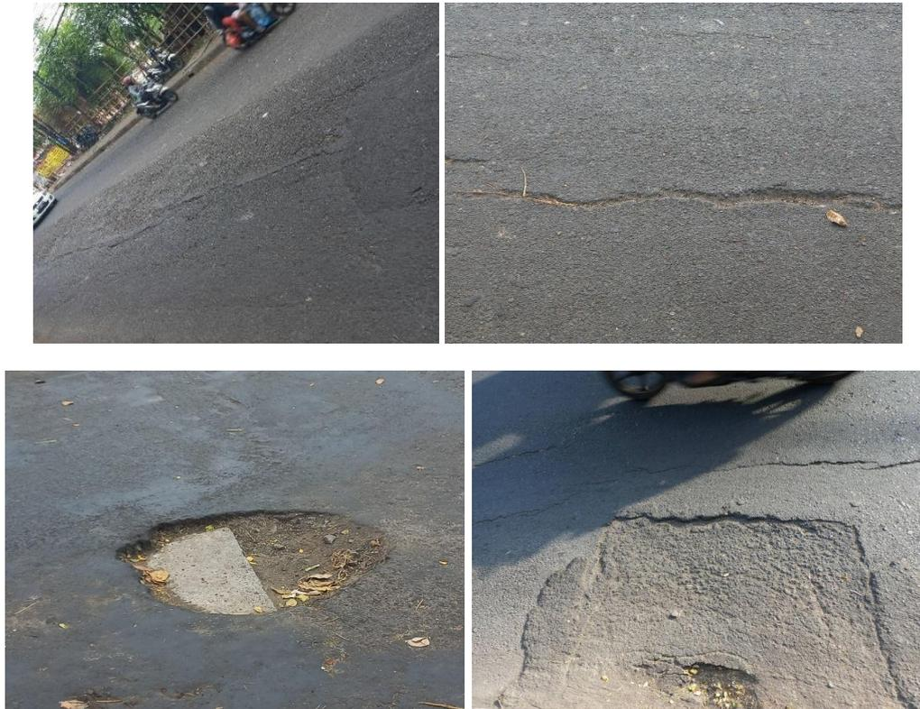
Gambar 4. Jenis Kerusakan Jalan yang terjadi pada sepanjang Jalan Gunung Agung, Denpasar (Kiri-Kanan : Pelepasan butir, Retak Memanjang, Kerusakan Amblas, Kerusakan Lubang)
