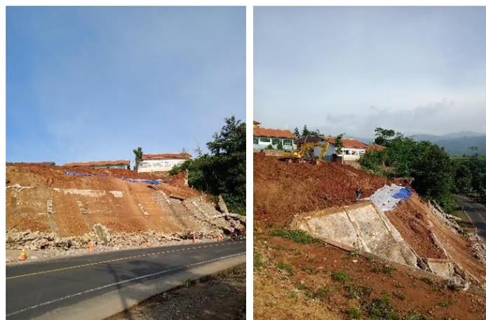
Gambar 2. Longsor yang terjadi setelah gempa 4,9 SR
