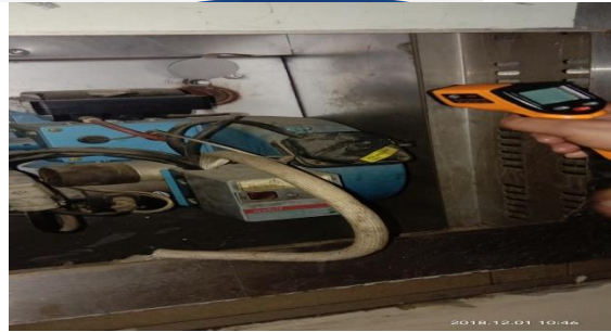
Gambar 4 Mengukur Temperatur Masuk dan Keluar dengan Menggunakan Thermometer Inframerah
