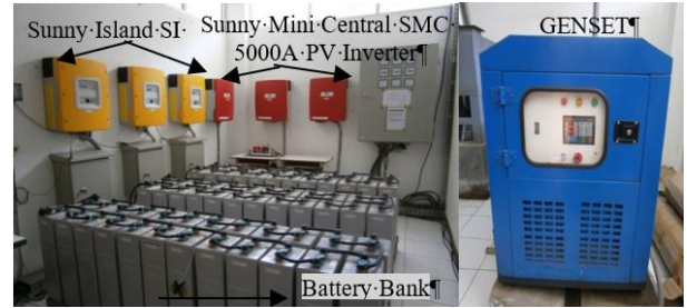
Gambar 2 : PLTS Hibrida (Tampak Dalam)
