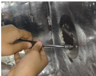
Gambar 5. Proses Pemasangan Damper
