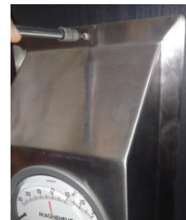
Gambar 9. Proses Pemasangan Alat Ukur
