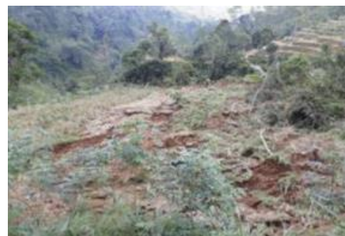
Gambar 2. Kelerengan tinggi berpotensi longsor di Dusun Pengungsan.
