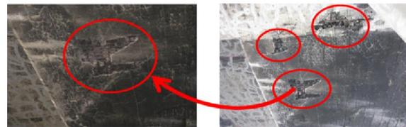
**Gambar 4.** Retak dan *Spalling* pada RC Box Girder Sisi Plaju Pasca Kebakaran
